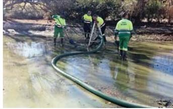
Han concluido los trabajos de limpieza del lago ubicado en la parte superior del Parque París. De la infraestructura, que tiene una superficie de 5.000 metros cuadrados, y una profundidad de 70 centímetros, se ha extraído el agua, para proceder a la retirada de lodos y residuos del fondo. Los peces fueron trasladados al lago en la zona inferior, que
