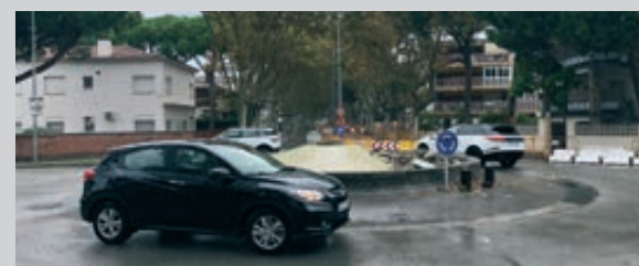
UNA IMAGEN DE LAS OBRAS DEL NUEVO CARRIL BICI DE LA AVENIDA PINEDA DE CASTELLDEFELS | EL LLOBREGAT
