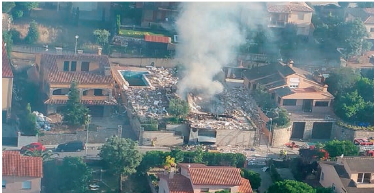
ASÍ QUEDÓ LA CASA DESPUÉS DE LA DEFLAGRACIÓN | SERVEI D'EMERGÈNCIES MÈDIQUES
