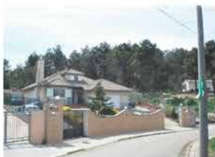
Lote 56 Vivienda Unifamiliar en Vidreres
