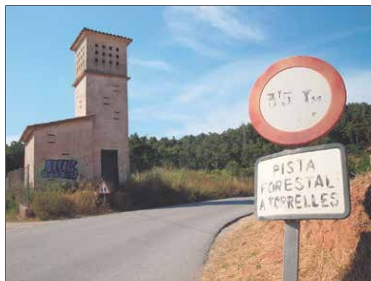
La pista ya está parcialmente asfaltada.
