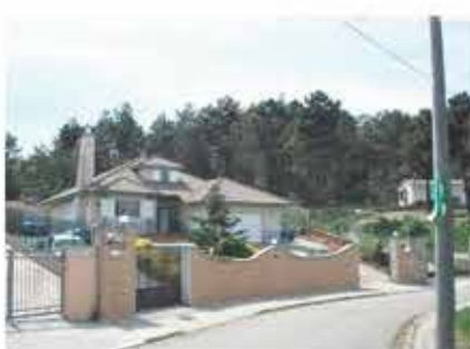
Lote 56 Vivienda Unifamiliar en Vidreres
