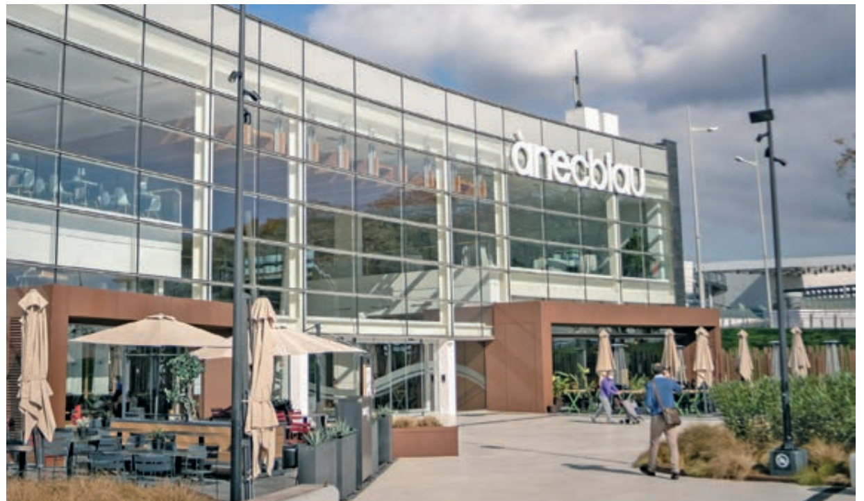
NUEVA FACHADA ACRISTALADA DE ÀNECBLAU DE CASTELLDEFELS
