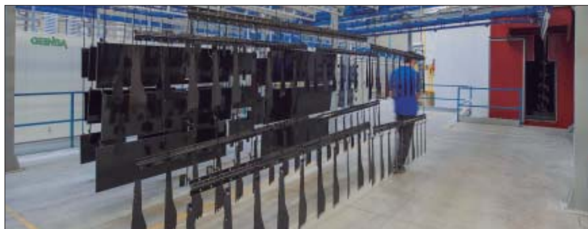
Instalación de pintura industrial que Geinsa para la empresa de tecnología electroestática, Exkal.
