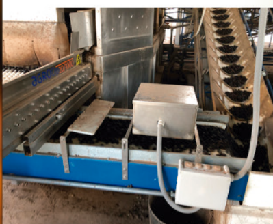
Fotos de instalaciones reales.
