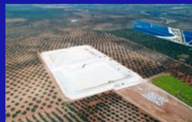
Balsas de almacenamiento/evaporación
