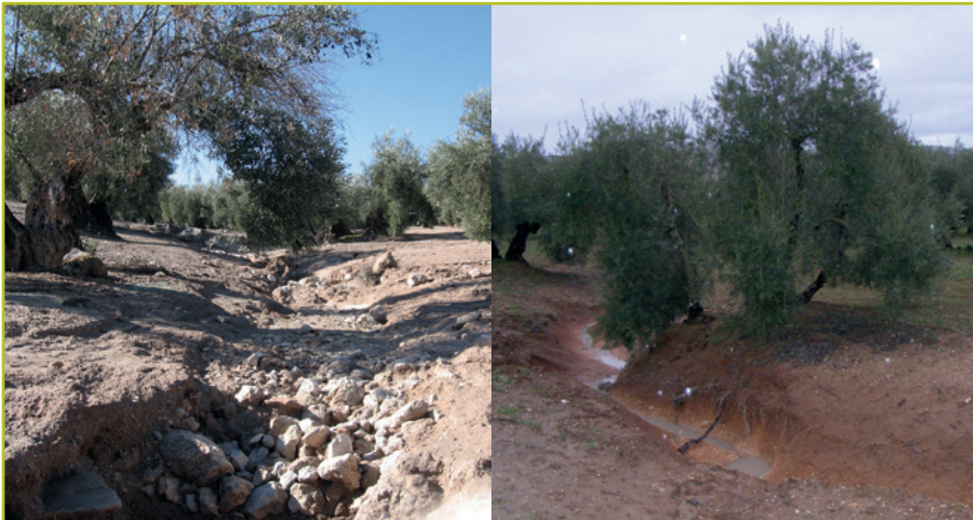
Figura 2. Elevadas pérdidas de suelo registradas en olivar con generación de cárcavas profundas.
