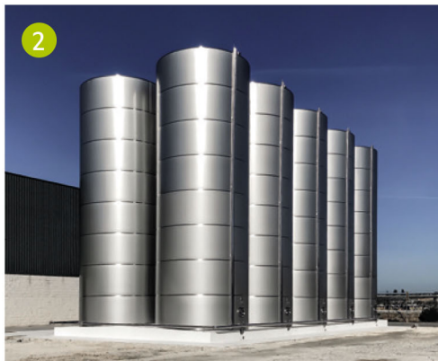
Automatización de bodegas (1); bodega con depósitos inox de gran capacidad (2); bodega para aceite de oliva en Lagar do Sobrado (Ferreira do Alentejo, Portugal) (3); bodega para aceite de oliva en Olibest (Serpa, Portugal) (4).
