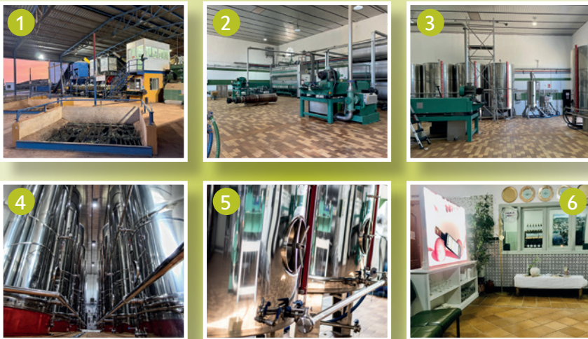
Instalaciones de la almazara de Aceites Ayozar en Castellar (Jaén). De izqda. a dcha., y de arriba a abajo, patio de recepción (1); zona de extracción (2 y 3); bodega (4 y 5); y tienda (6).
