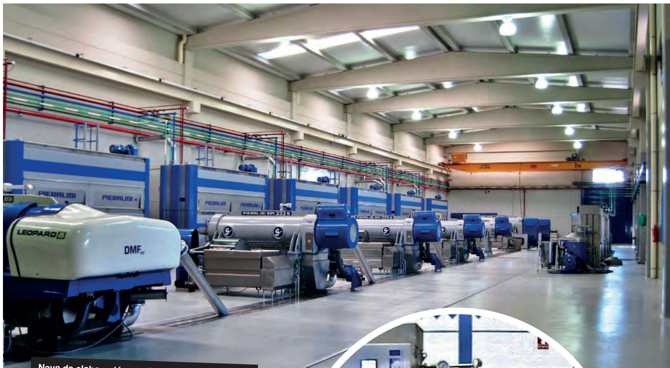
Nave de elaboración con batidoras y decánters.
