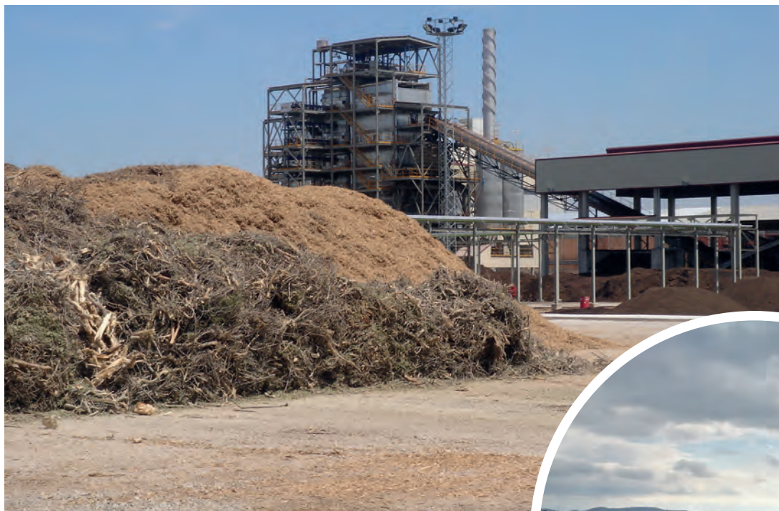
Planta de generación de energía eléctrica mediante combustión con biomasa del olivar.
