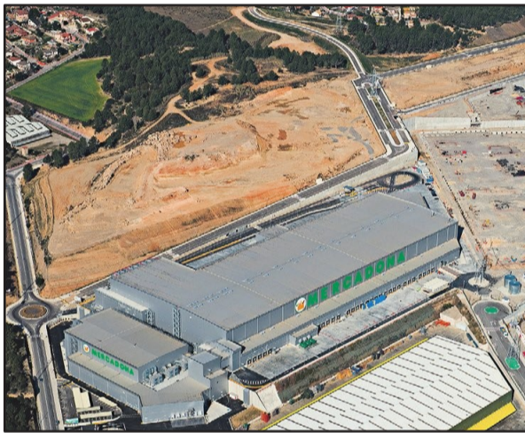
Imagen aérea de la nave de frío del bloque logístico en Abrera
