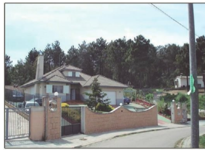
Lote 56 Vivienda unifamiliar en vidreres
