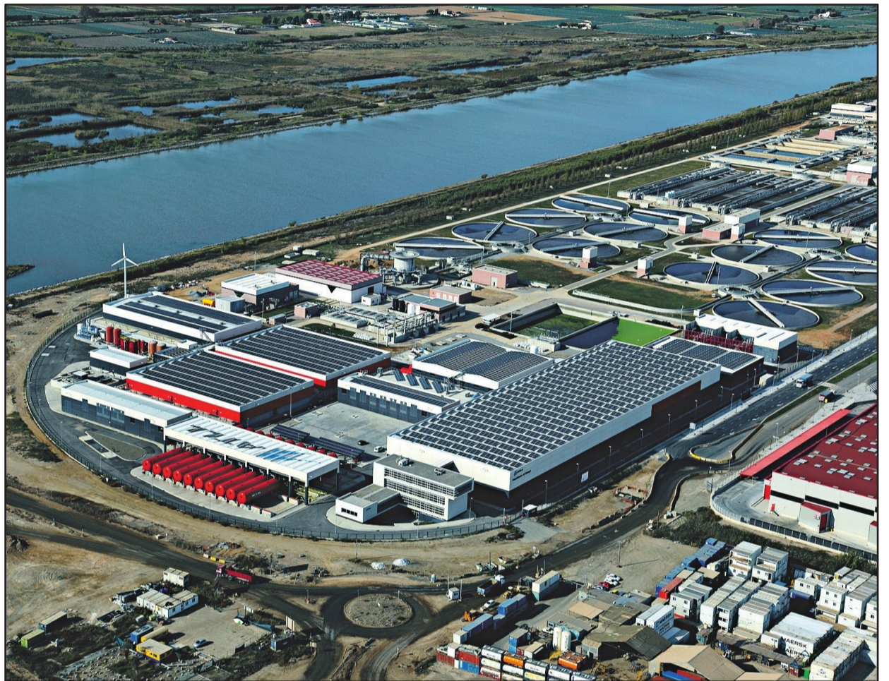
Imagen aérea de la desaladora de El Prat, la más importante de su tipo en toda Europa
