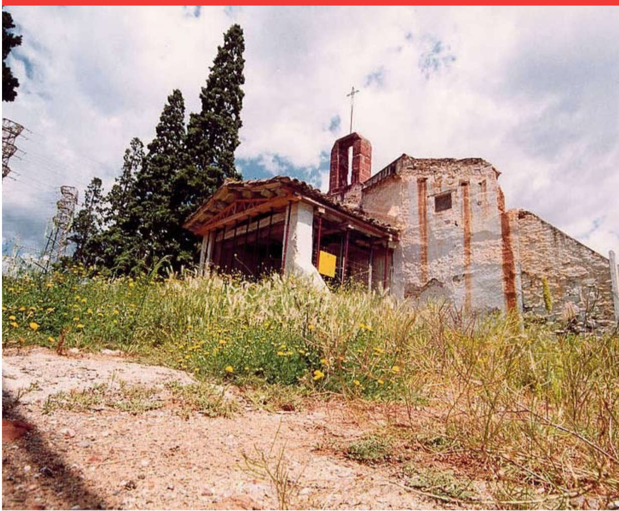
Imatge de l'ermita de Sales de Viladecans anterior a la rehabilitació.
