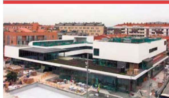
Estat actual de les obres de la nova biblioteca.
