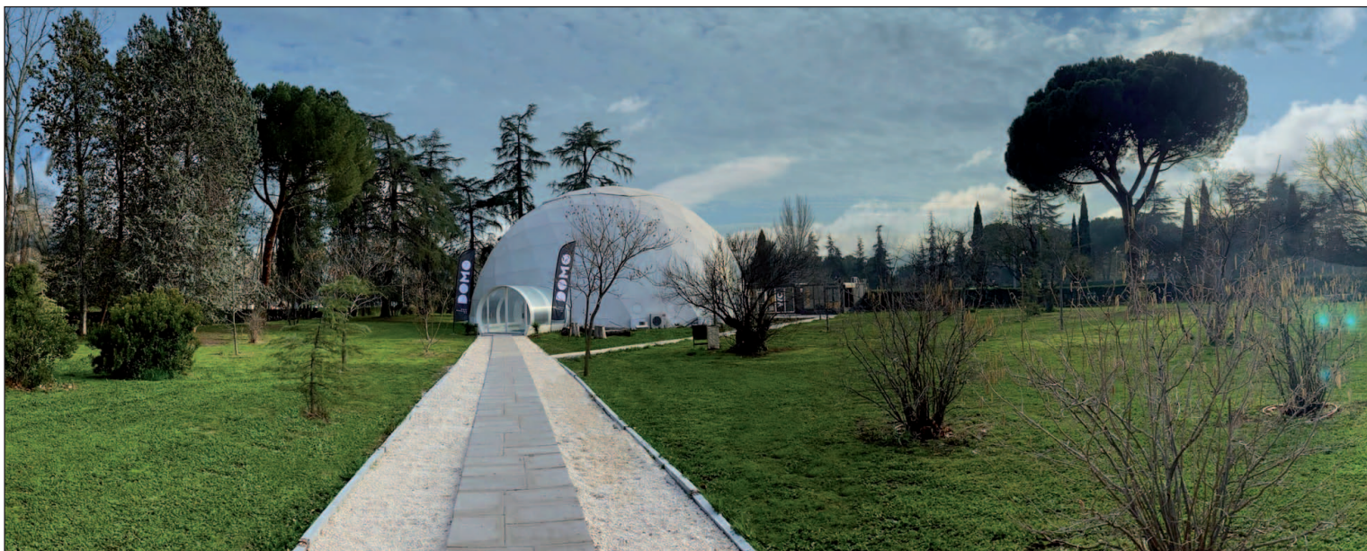
Domo cuenta con más de 2.500 metros cuadrados de jardines, además de parking privado y público y fácil acceso desde transporte público.
