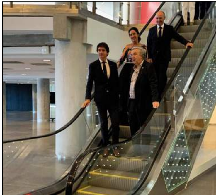
Una de las nuevas escaleras mecánicas del Palacio Euskalduna.
