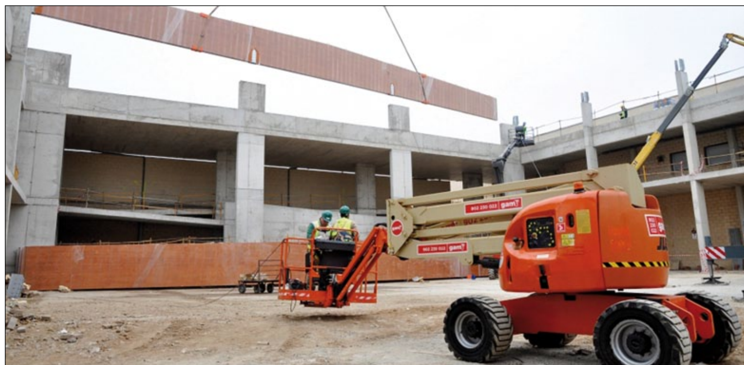
Momento en el que los operarios se disponen a colocar la primera de las ocho grandes vigas de madera encolada que se instalarán.
