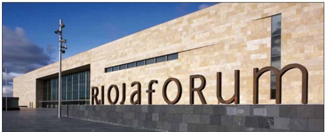
El Palacio de Congresos y Auditorio de La Rioja cuenta con amplias y modernas instalaciones.
