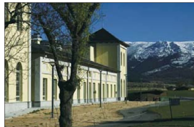
Aspecto actual del edificio del Palacio de La Faisanera.
