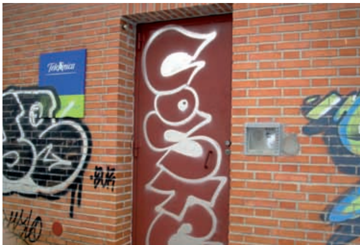
La central de Telefónica del Pueblo que, al igual que la de la Colonia, tiene un aspecto descuidado y lleno de pintadas
