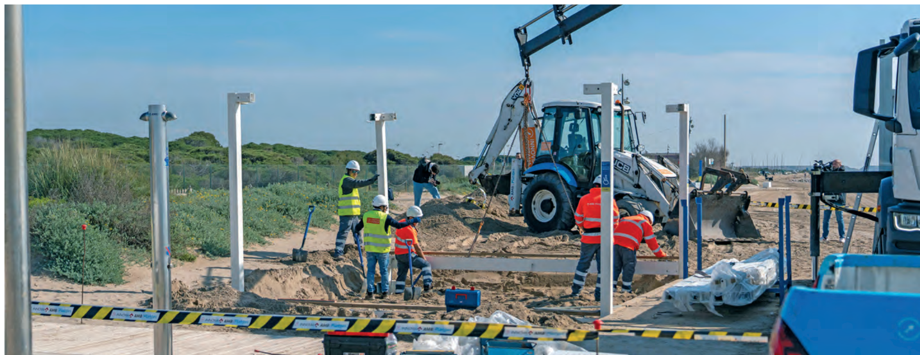
IMATGE DEL PROCÉS DE MUNTATGE DEL MOBILIARI I EQUIPAMENTS IMPRESCINDIBLES A LES PLATGES METROPOLITANES. AQUEST ESTIU S'HAN COL·LOCAT TRES NOUS MÒDULS DE PRIMERS AUXILIS I QUATRE NOUS MÒDULS AUXILIARS DE SALVAMENT
