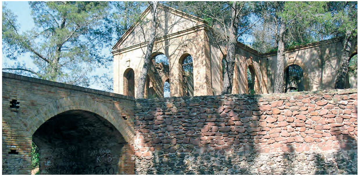
RESTES ENCARA EN PEUS DE L'EDIFICI PRINCIPAL DE LES MINES DEL PLOM DE CASTELLVÍ DE ROSANES (FOTO: ARXIU HISTÒRIC)
