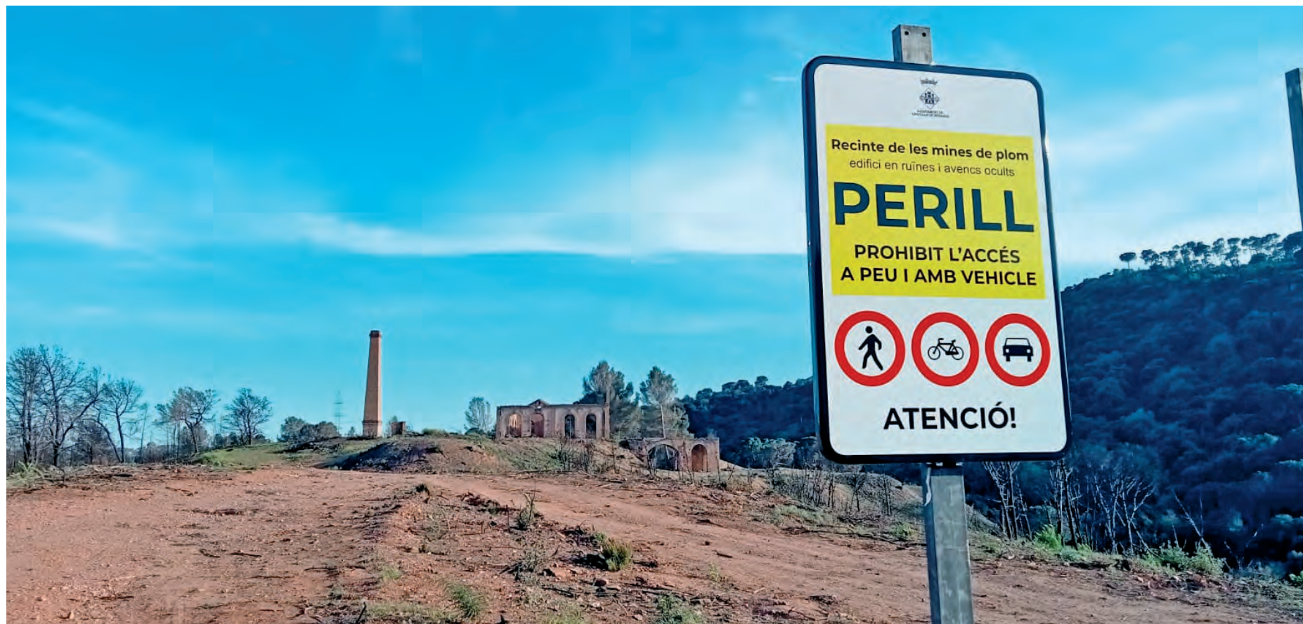
TOT I SER UN ESPAI PRIVILEGIAT NO ÉS ACCESSIBLE PER RAONS DE SEGURETAT. L'AJUNTAMENT DONA L'AVÍS DE PROHIBICIÓ TANT EN L'ACCÉS A LES INSTAL·LACIONS COM A L'ENTORN, INDICANT DEL PERILL AMB CARTELLS INFORMATIUS
