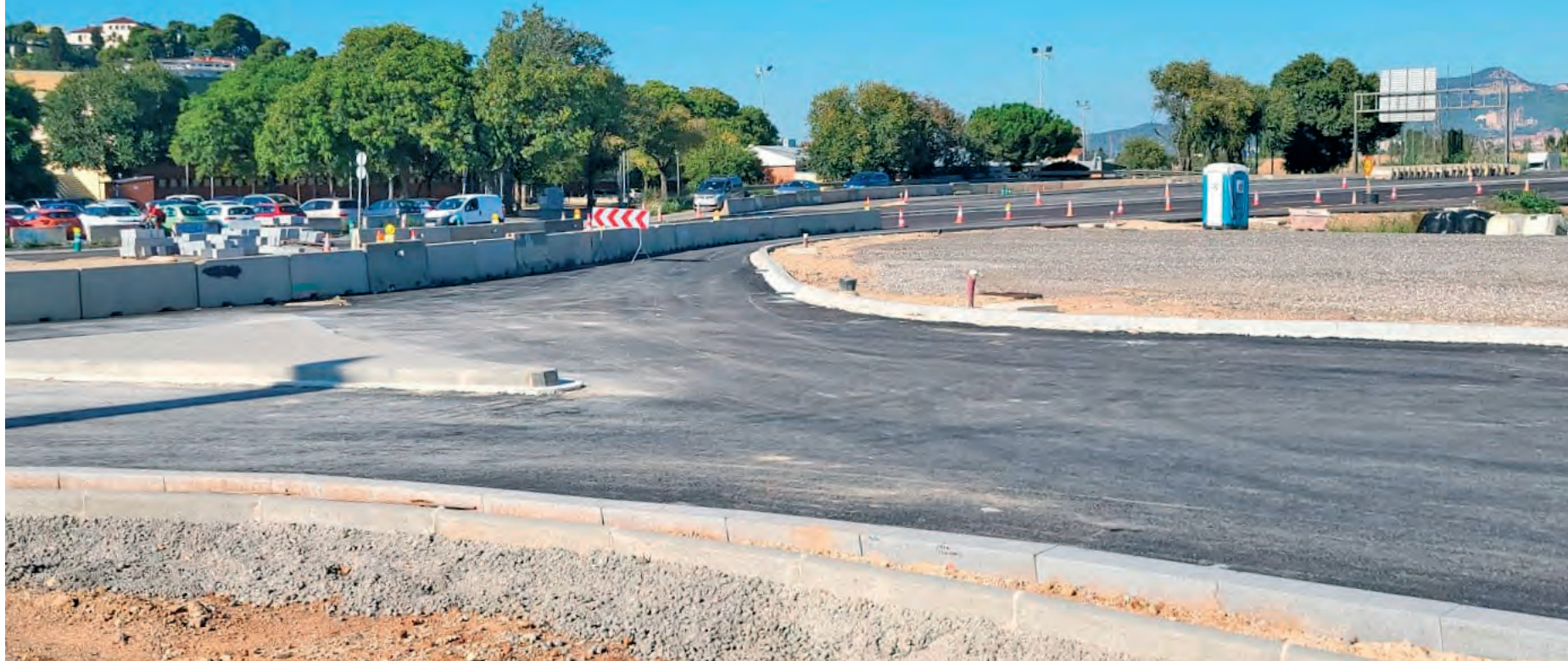
OBRAS DE CONSTRUCCIÓN DE LA 'NUEVA' ROTONDA DE LA PARELLADA QUE DISTRIBUIRÁ EL TRÁFICO LOCAL ENTRE LA B-25 Y SANT BOI, CON LA PROLONGACIÓN DE LA CALLE SARAGOSSA (A LA DERECHA DE LA FOTO) RECIÉN PAVIMENTADA
